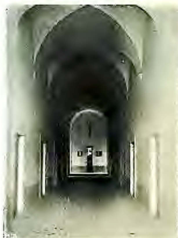
Dormitorio del Noviziato - Corridoio interno
